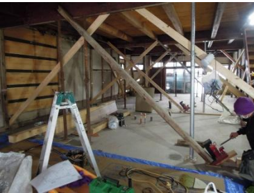
写真4 耐力壁工事
