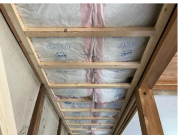
写真5 断熱材敷工事
