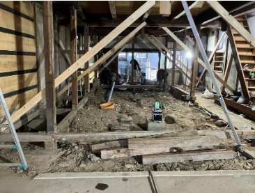
写真2 床鉄筋コンクリート工事
